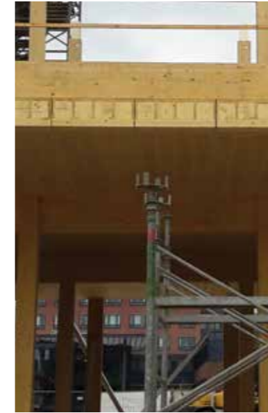
↓ Holzskelett während der Montage
