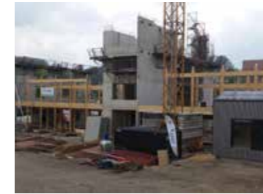
< Montage des Holzbaus > Unverkleidetes Holzskelett mit aufliegender Holzhohlkastendecke
